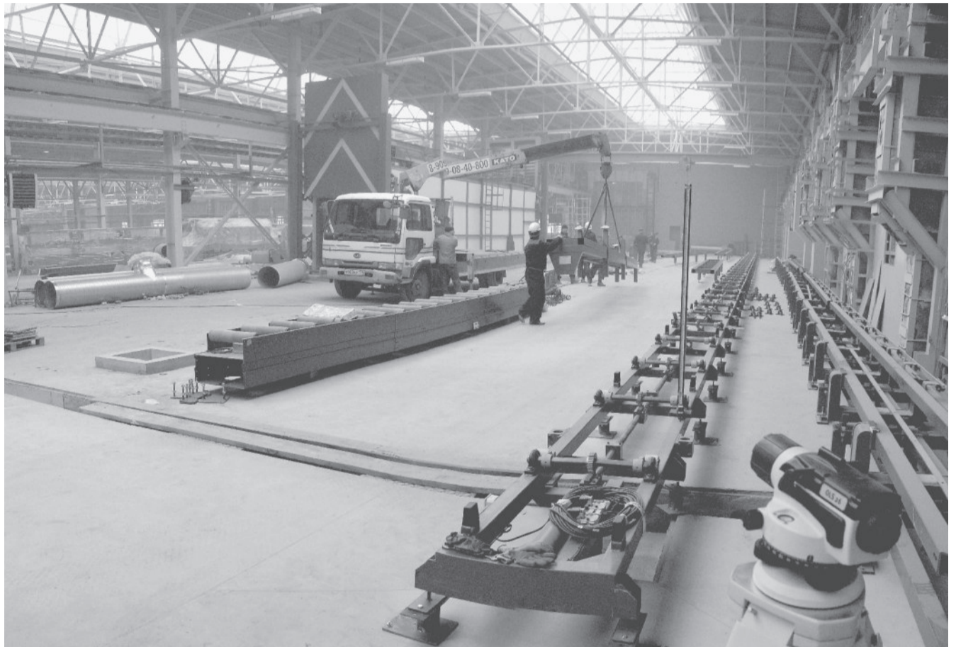
ПЕРВАЯ ЛИНИЯ. Всего установят три линии столов, по которым алюминиевые заготовки после экструзии будут переноситься на установку растяжки. Фото В. Голынкина.
